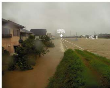
宮崎市下小松 支川大谷川油出橋下流
