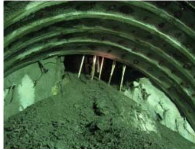
写真-2 天端崩落状況 (STA301+98.7)
