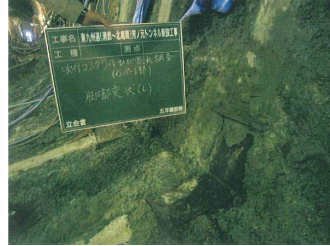
写真-3 脚部の座屈状況 (STA302+17.7)
