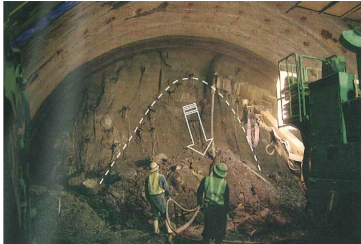
写真-1 切羽崩壊状況 (STA301+98.7)
