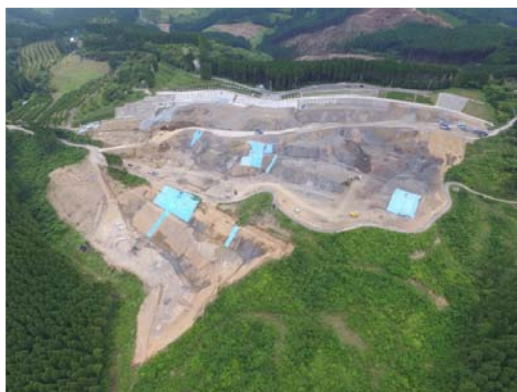
■頭部排土施工状況（H28.5）
