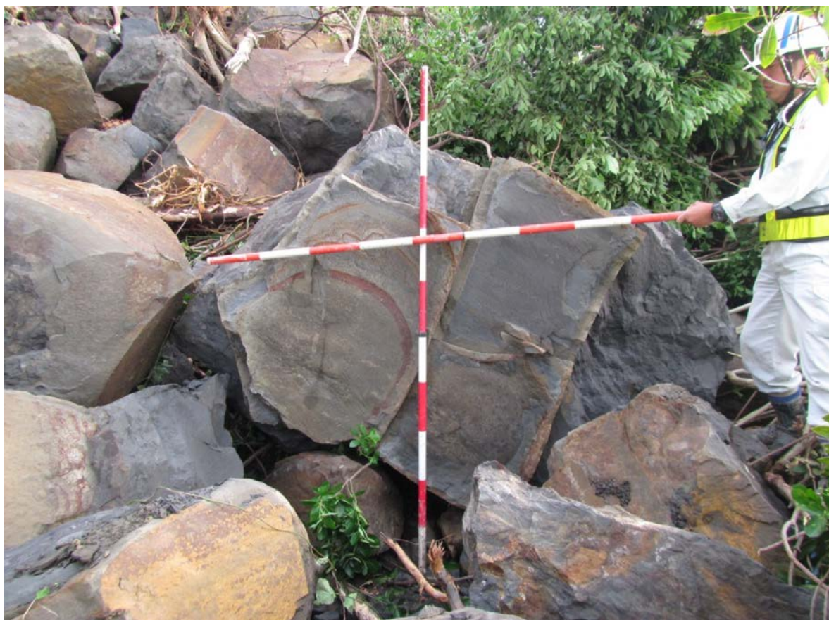
《崩壊状況①》6月21日6時頃
