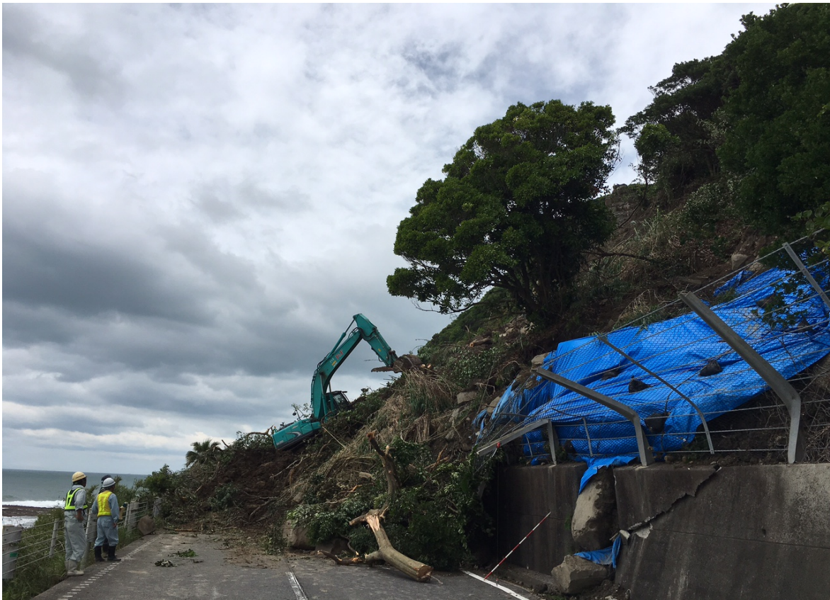
《進入路造成①》6月21日10時頃
