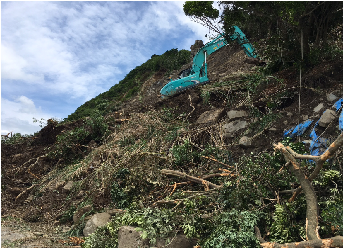
《進入路造成②》6月21日11時
