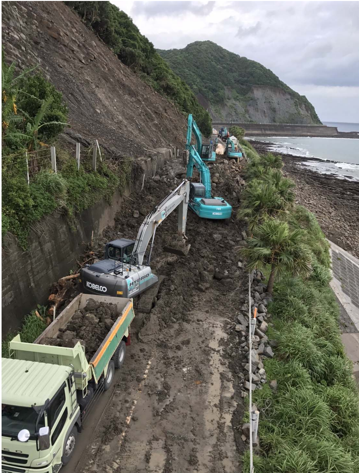
《土砂撤去状況④》6月25日11時頃
