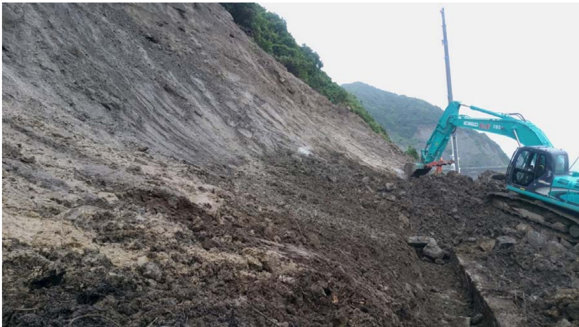
《土砂撤去状況①》6月24日17時頃
