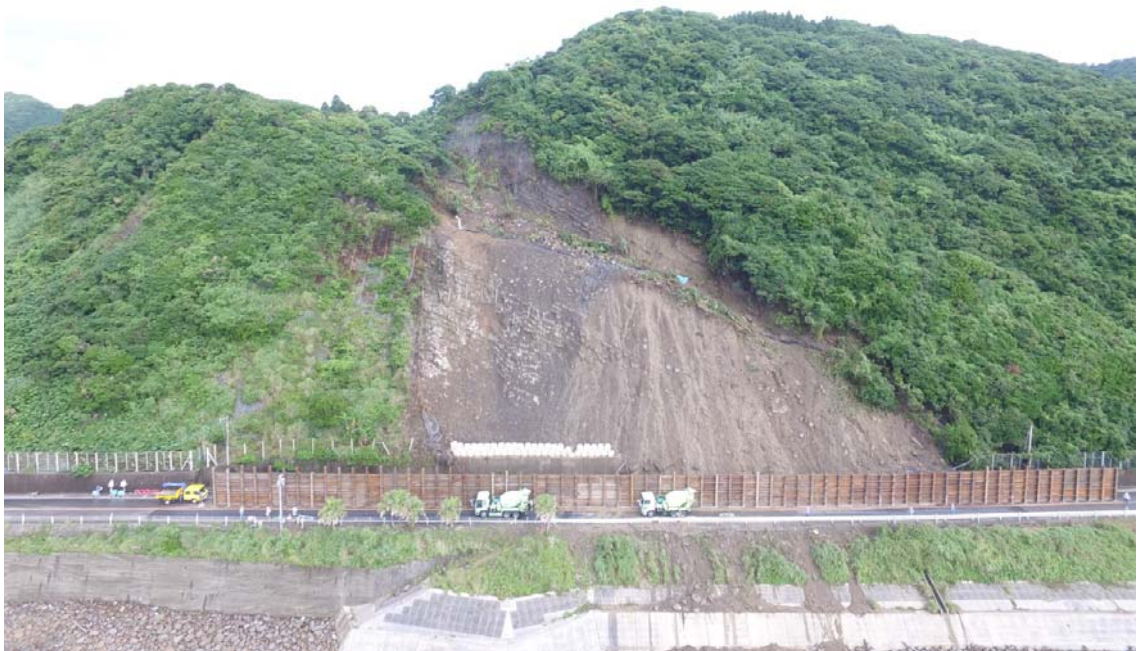
《海側からの全景③》 6月28日8時頃
