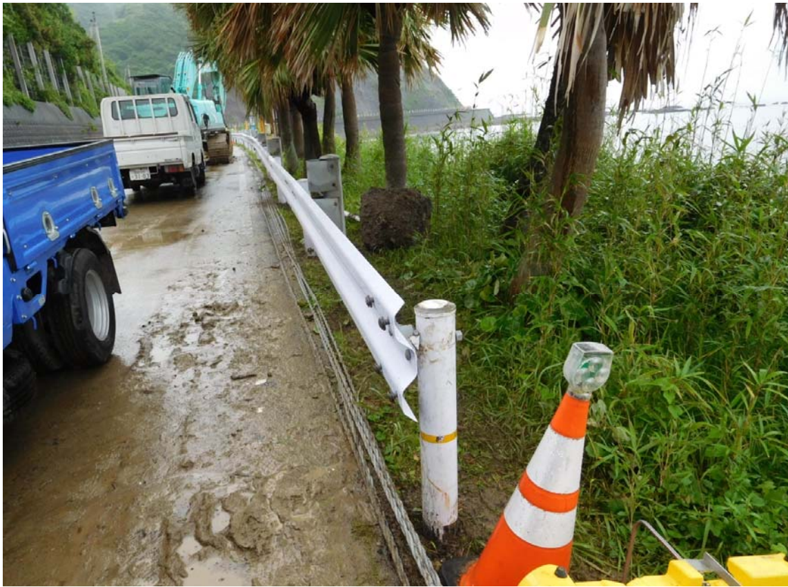
《ガードレール設置状況》 6月26日16時頃
