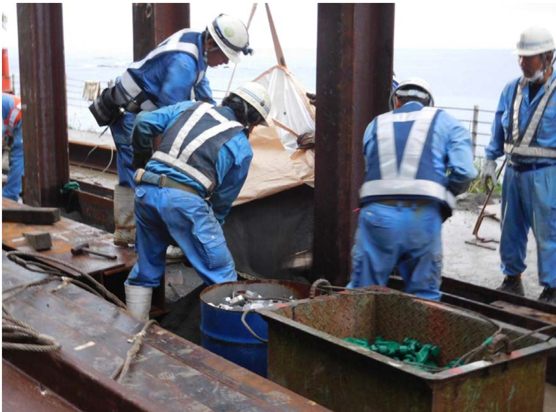
《仮設防護柵設置(削孔への土砂充填状況)》 6月26日19時頃
