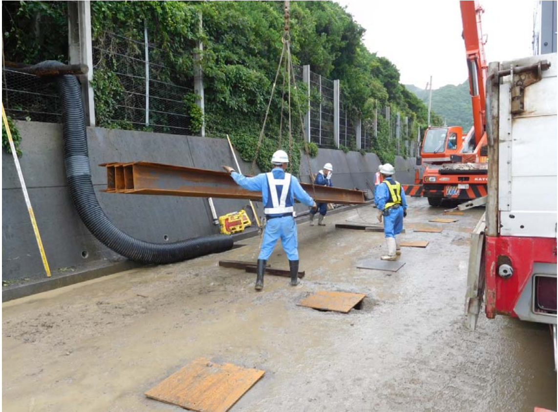
《仮設防護柵設置(H鋼運搬状況)》 6月26日17時頃
