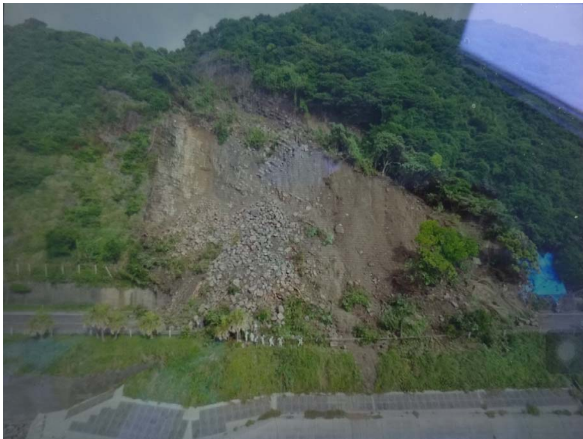
《海側からの全景①》6月21日9時頃
