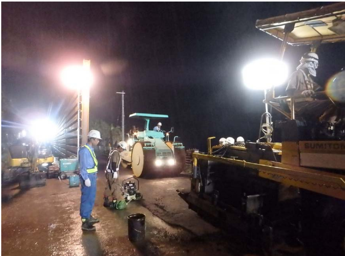
《舗装状況)》 6月28日3時頃
