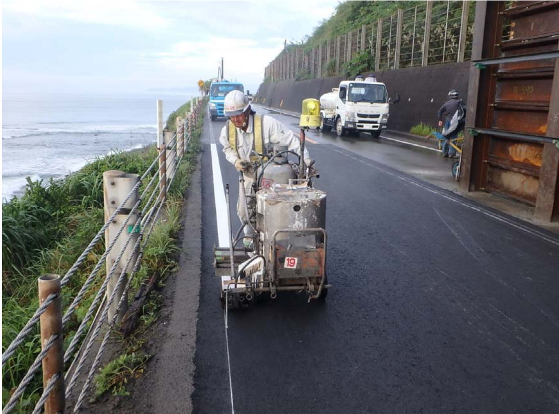
《区画線引き状況》 6月28日6時頃
