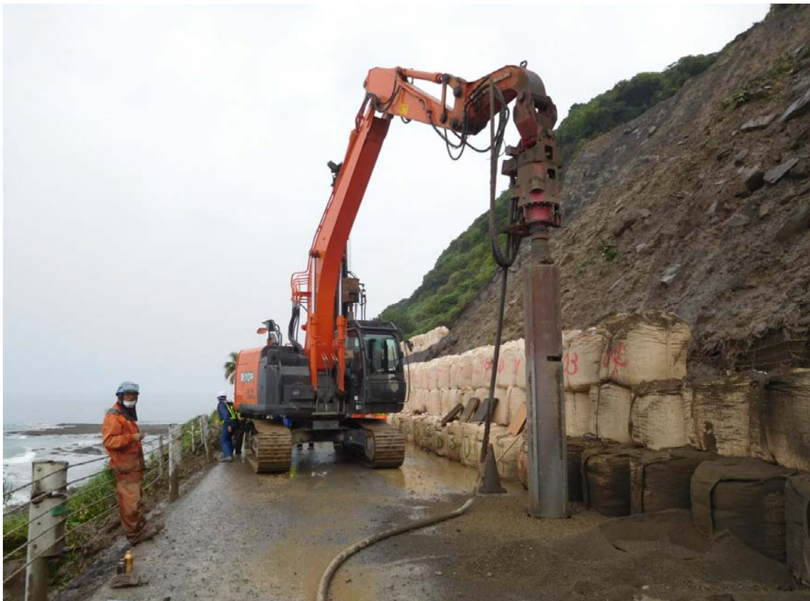
《仮設防護柵設置(削孔状況①)》 6月26日16時頃
