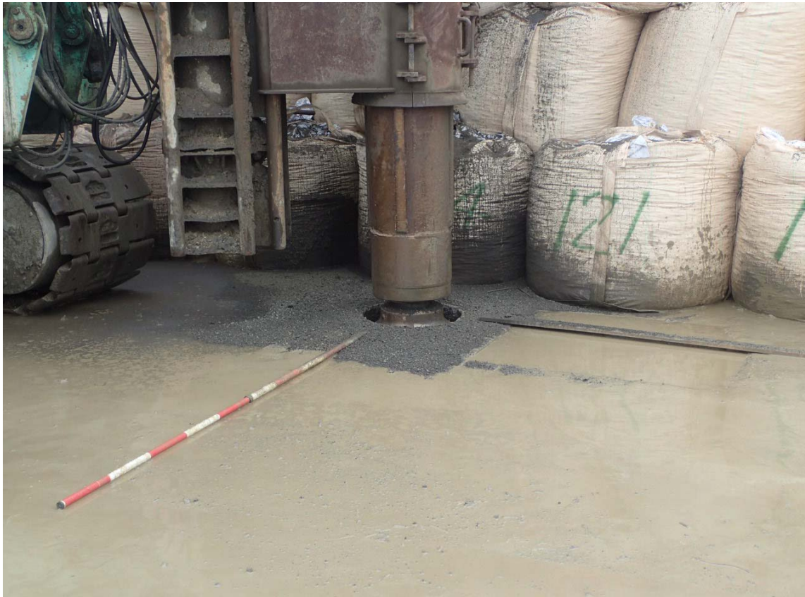
《仮設防護柵設置(削孔状況②)》 6月26日16時頃
