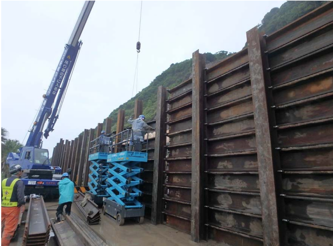
《仮設防護柵設置(鋼矢板設置状況)》 6月27日9時頃
