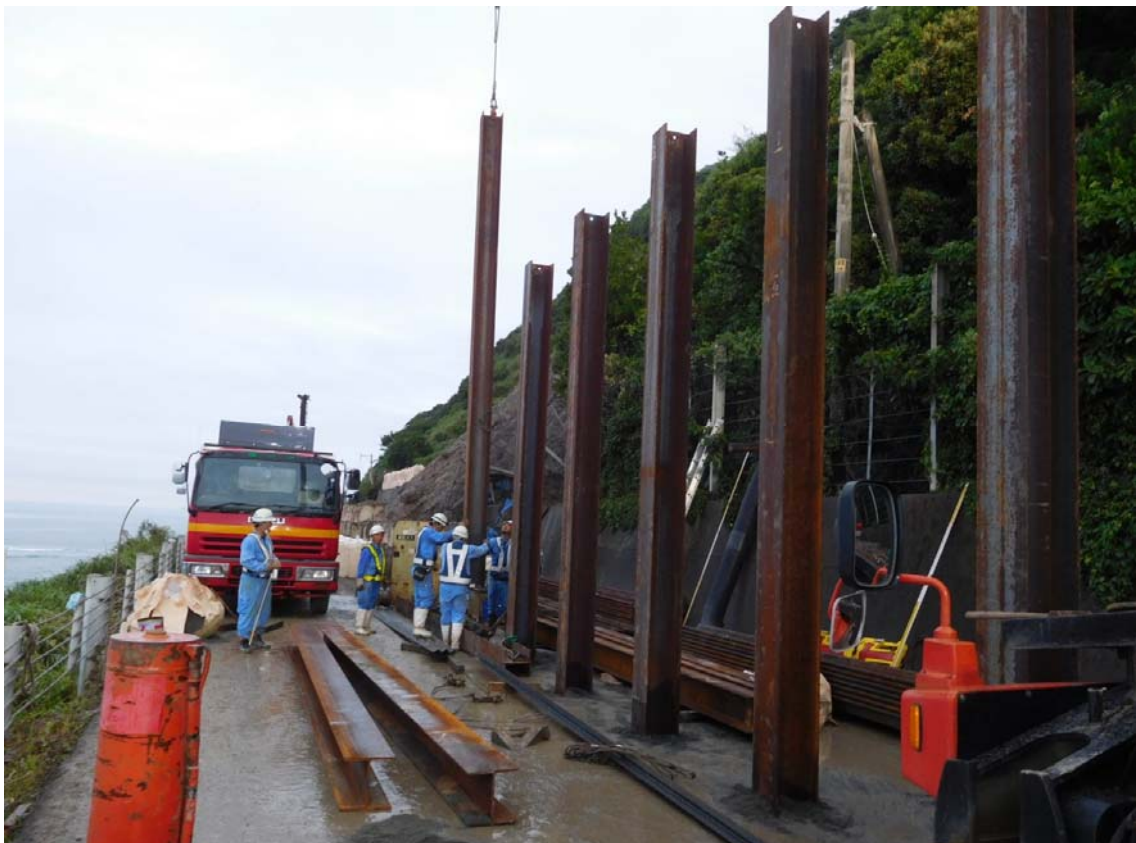
《仮設防護柵設置(H鋼設置状況)》 6月26日19時頃
