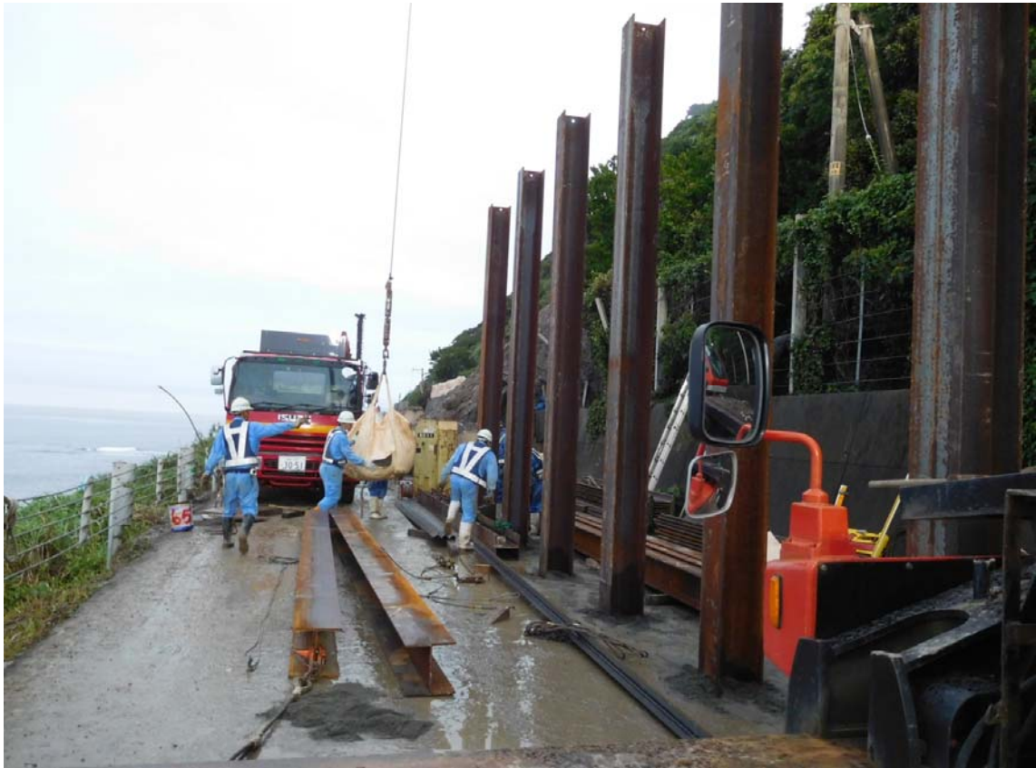
《仮設防護柵設置(大型土のう運搬状況)》 6月26日19時頃
