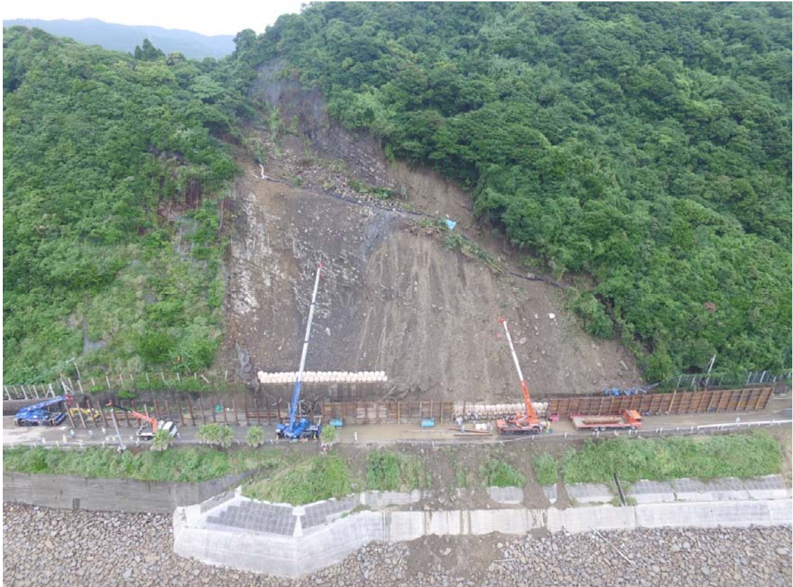
《海側からの全景②》 6月27日13時頃
