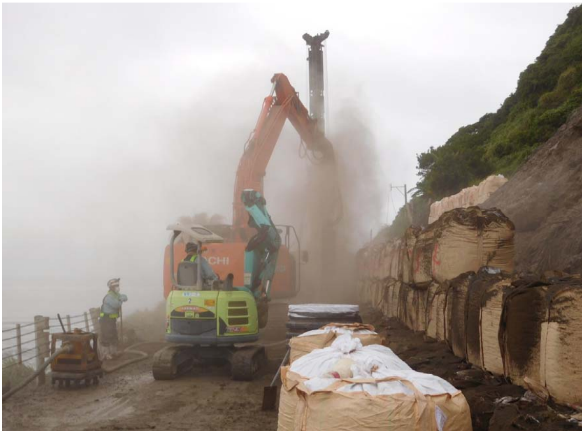
《仮設防護柵設置(削孔状況③)》 6月26日19時頃
