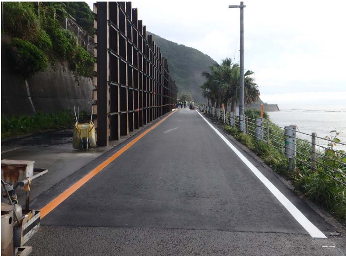
《舗装・区画線完了》 6月28日7時頃
