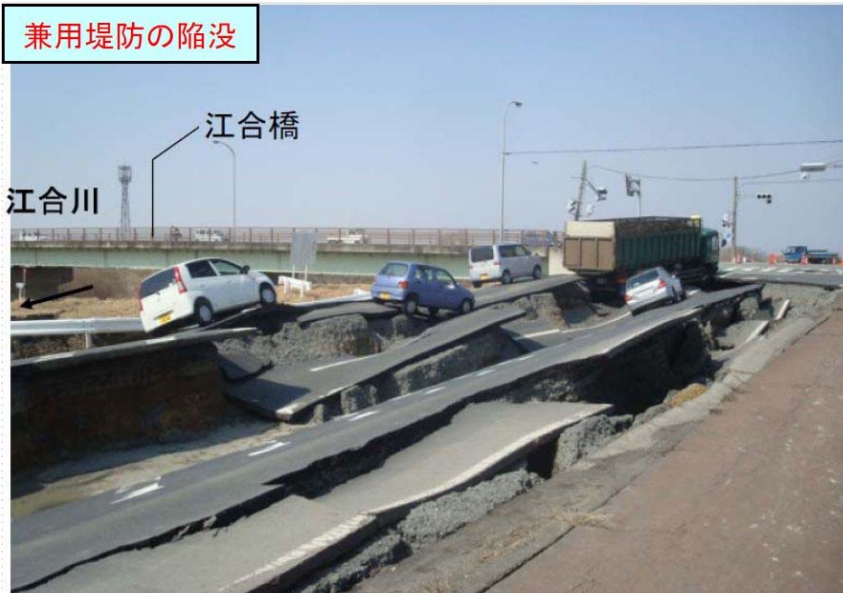
東北地方太平洋沖地震による堤防の陥没状況
