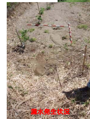
堤防漏水の発生事例(小丸川左岸4k400付近)
