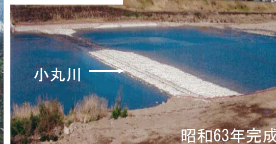
床止めの状況
