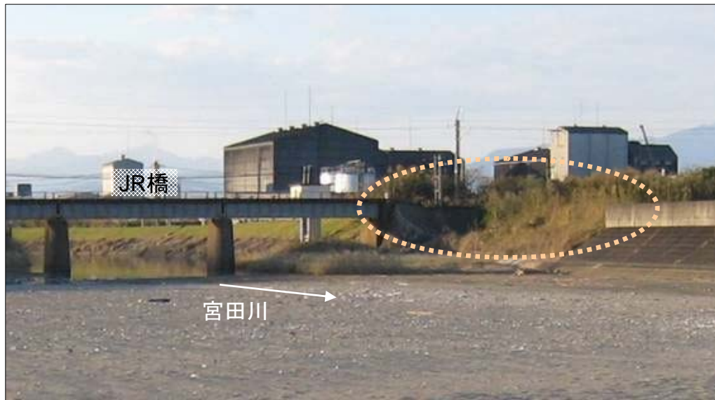
堤防の未整備箇所(宮田川左岸)
