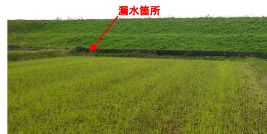
堤防漏水の発生事例(小丸川左岸4k400付近)
