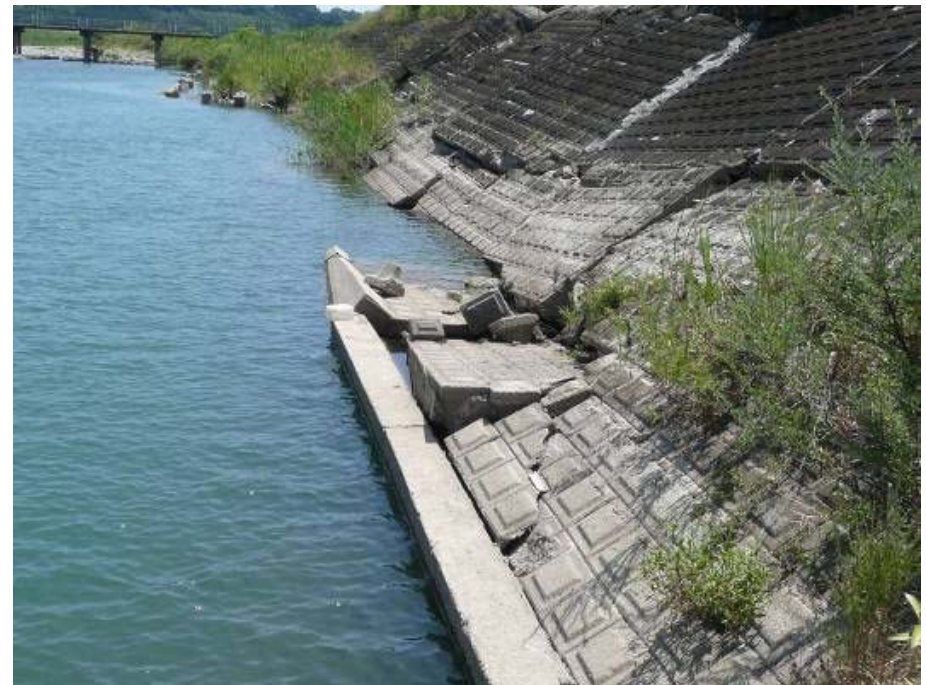
護岸崩落状況(4/700~4/780右岸)
