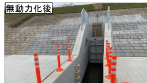
○大淀川水系における無動力化の事例（古川排水樋管）
