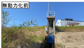
○大淀川水系における無動力化の事例（古川排水樋管）
