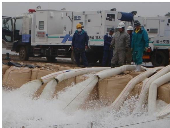
写真 4-3-7 排水ポンプ車による排水活動
