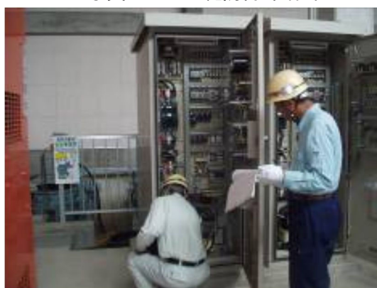
写真 4-3-5 電気設備の点検状況
