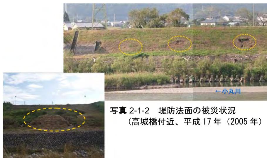
写真 2-1-2 堤防法面の被災状況
