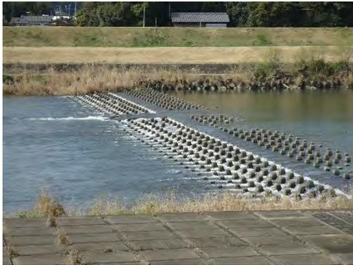
写真 2-1-8 床止め(小丸川床止め：小丸川)
