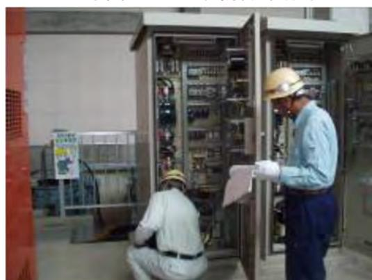
写真 4-3-5 電気設備の点検状況
