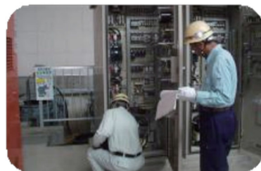
○電気設備の点検状況
