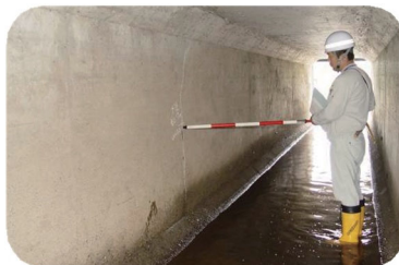
○樋門の保守点検
