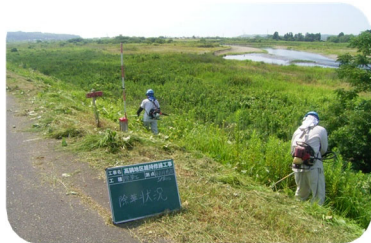
○堤防除草作業
