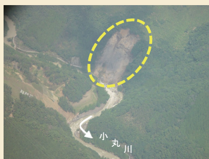
○小丸川上流部（山腹崩壊状況）
