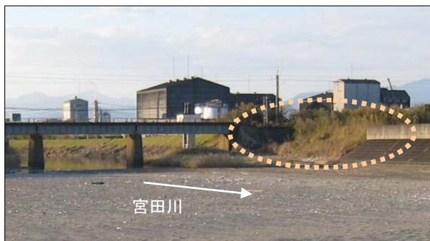
写真 2-1-5 堤防の未整備箇所の状況(宮田川)
