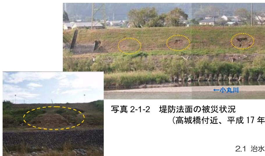
写真 2-1-2 堤防法面の被災状況
