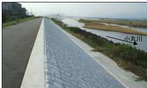
写真 2-1-4 高潮堤防の整備状況 (高鍋町蚊口地区)
