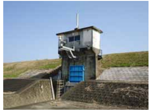
写真 2-1-9 樋管(持田樋管：小丸川)
