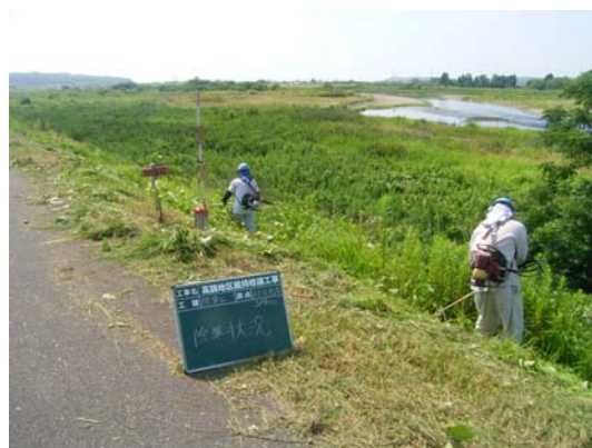
写真 4-3-3 堤防除草作業
