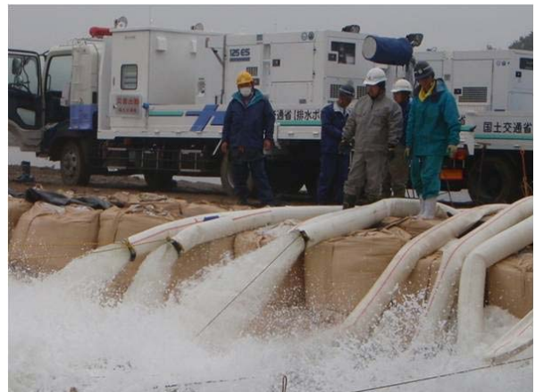
写真 4-3-7 排水ポンプ車による排水活動
