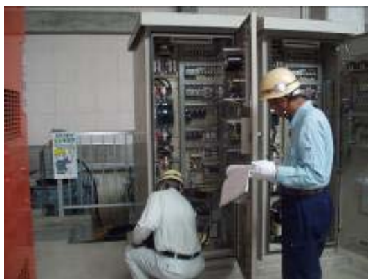
写真 4-3-5 電気設備の点検状況
