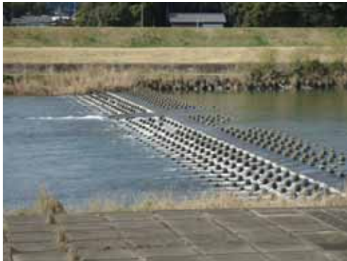
写真 2-1-8 床止め(小丸川床止め：小丸川)
