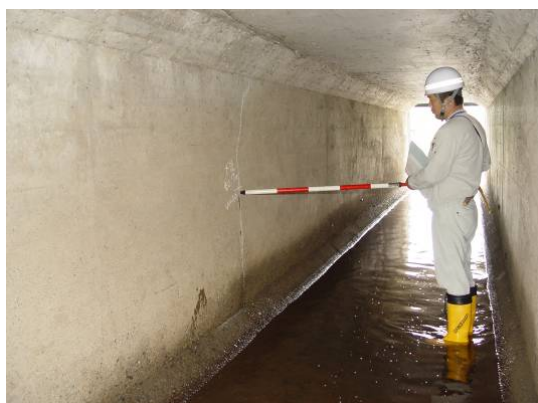
写真 4-3-4 樋門の保守点検
