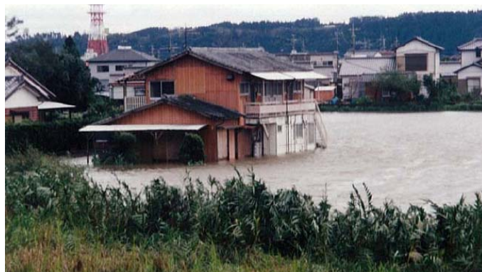
写真1-2-2 平成9年9月洪水の浸水被害状況(高鍋町)
