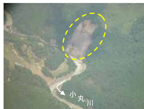
写真 2-1-7 小丸川上流部の山腹崩壊状況
