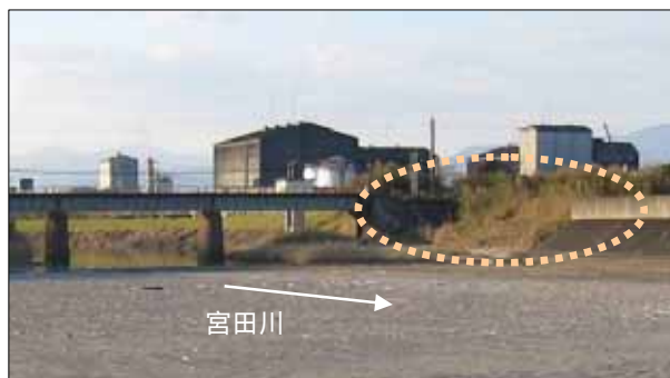
写真 2-1-5 堤防の未整備箇所(宮田川)
