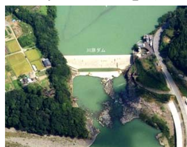
川原ダム（九州電力）
