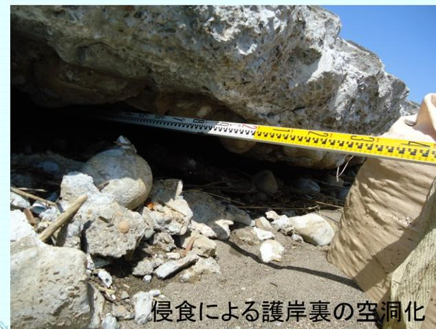
侵食による護岸裏の空洞化
