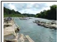
＜観音瀬＞ 寛政3年（1791）から6年にかけて、川船が通行できるように掘削した岩瀬。
