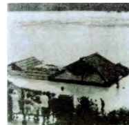
軒先まで浸水した家(高岡町)
