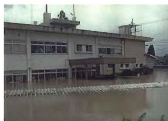
■内山地区の浸水状況(宮崎市高岡町)
