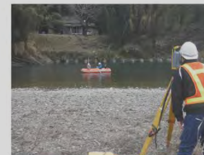
写真 5.2.1 河道の横断測量
