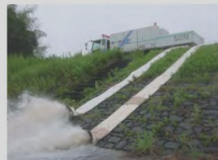
写真 4.3.5 排水ポンプ車の稼働状況 (平成 17 年 台風 14 号出水時)
