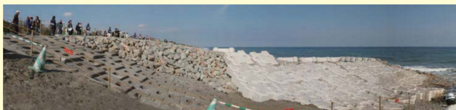
突堤現地見学会による実物の確認 (第20回宮崎海岸市民談義所)
