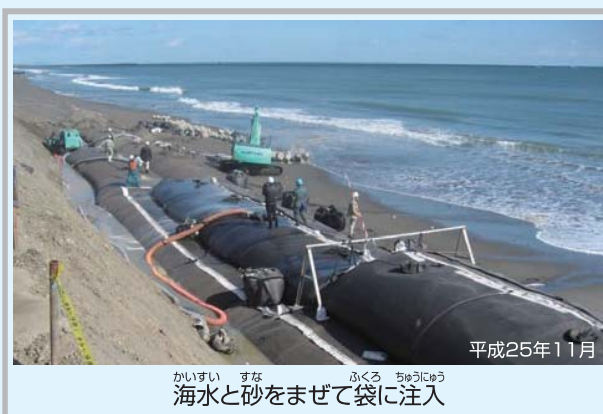
サンドバックの設置(大炊田地区)
