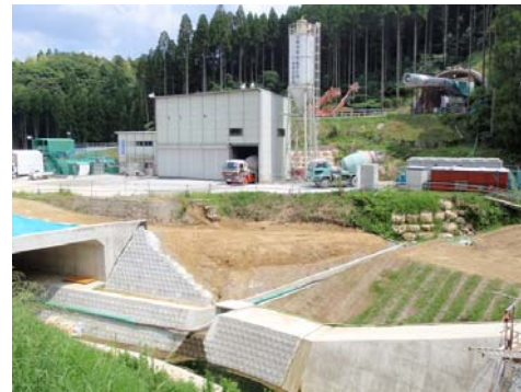
トンネル坑口 (丸目トンネル)
