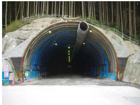
トンネル坑口 (芳ノ元トンネル)
