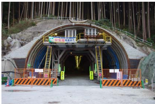
トンネル坑口 (芳ノ元トンネル)
