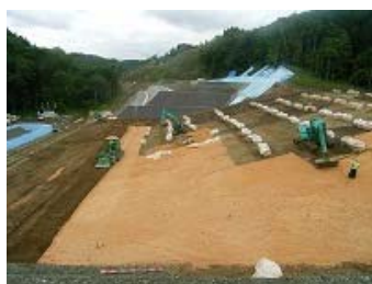
吸着材の敷き均し
