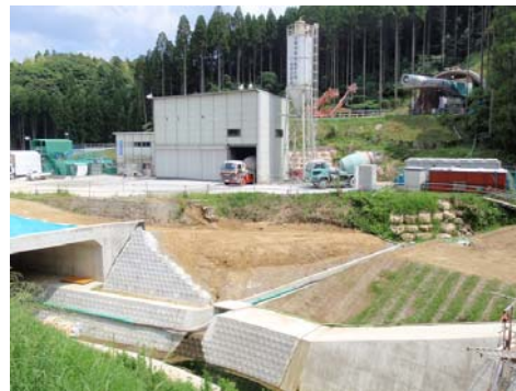
トンネル坑口 (丸目トンネル)
