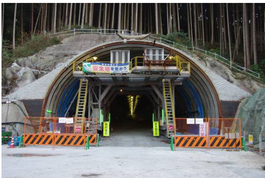
トンネル坑口 (芳ノ元トンネル)
