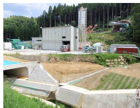
トンネル坑口 (丸目トンネル)
