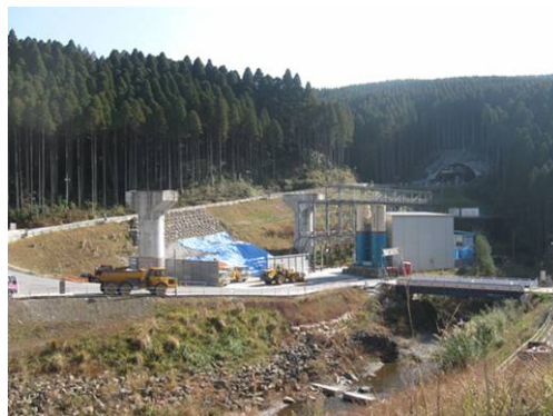
芳ノ元トンネル工事場所全景
