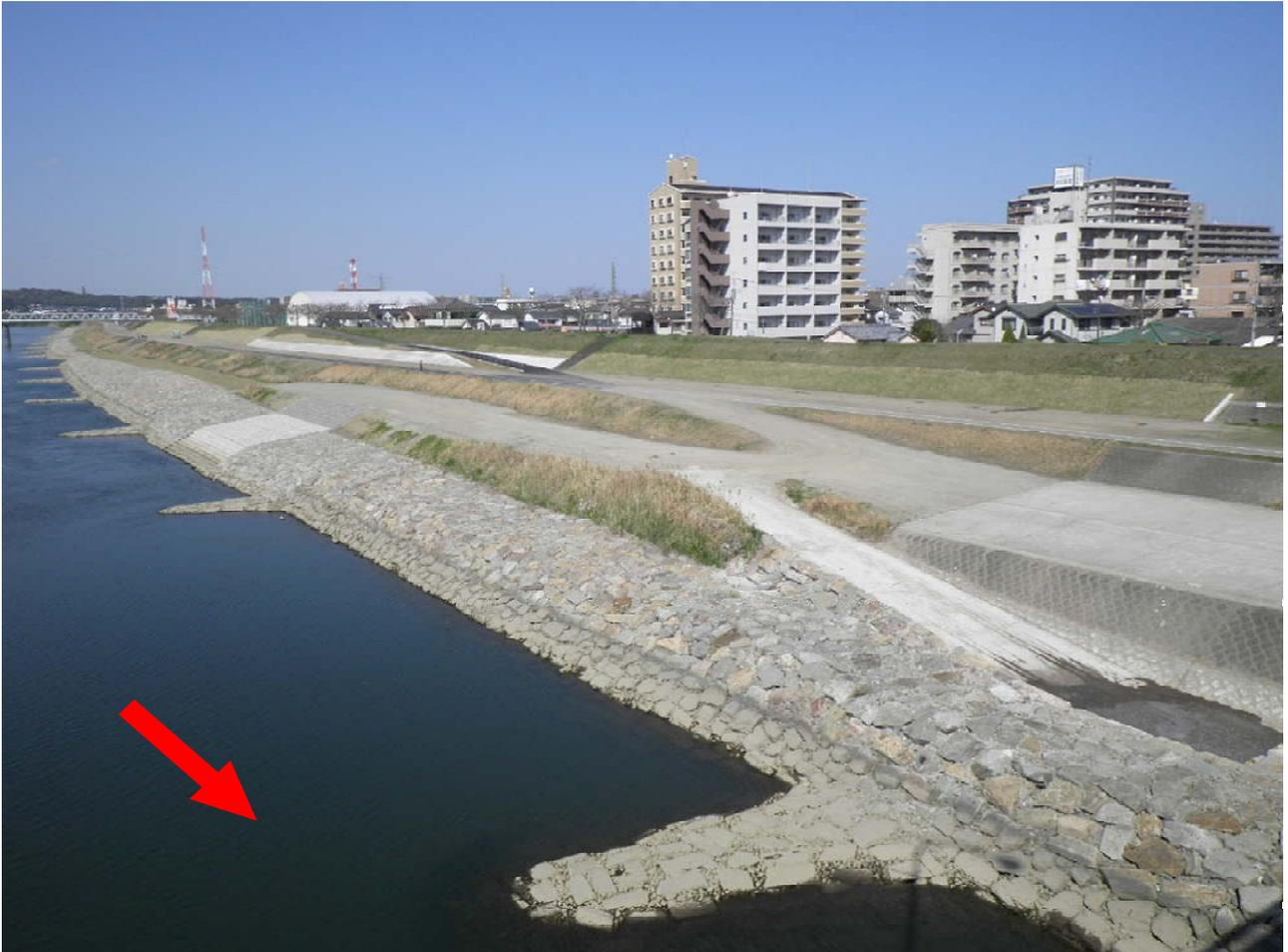
大淀川 完成した堤防浸食対策工（護岸工）
