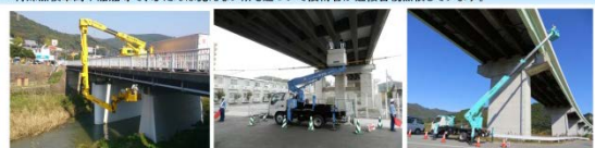
橋梁点検車による点検
