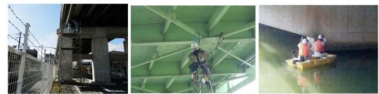
足場設置による点検
