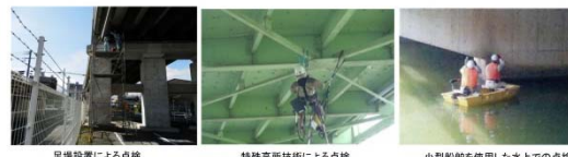
足場設置による点検
