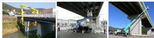
橋梁点検車による点検
