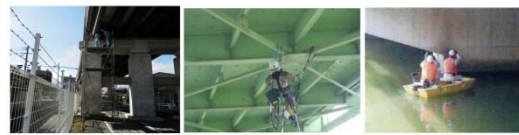
足場設置による点検
