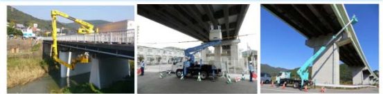
橋梁点検車による点検
