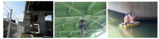
足場設置による点検
