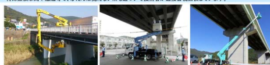
橋梁点検車による点検
