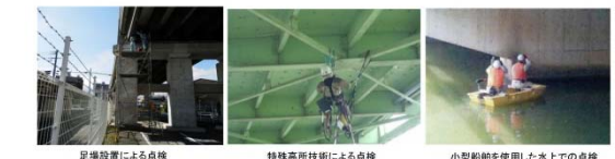
足場設置による点検
