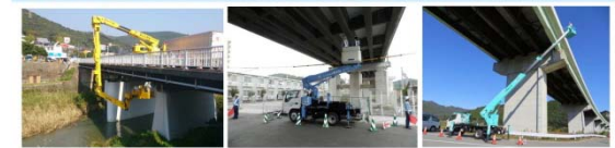
橋梁点検車による点検
