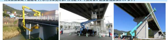
橋梁点検車による点検
