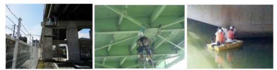
足場設置による点検 特殊高所技術による点検 小型船舶を使用した水上での点検
