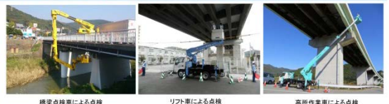
橋梁点検車による点検 リフト車による点検 高所作業車による点検
