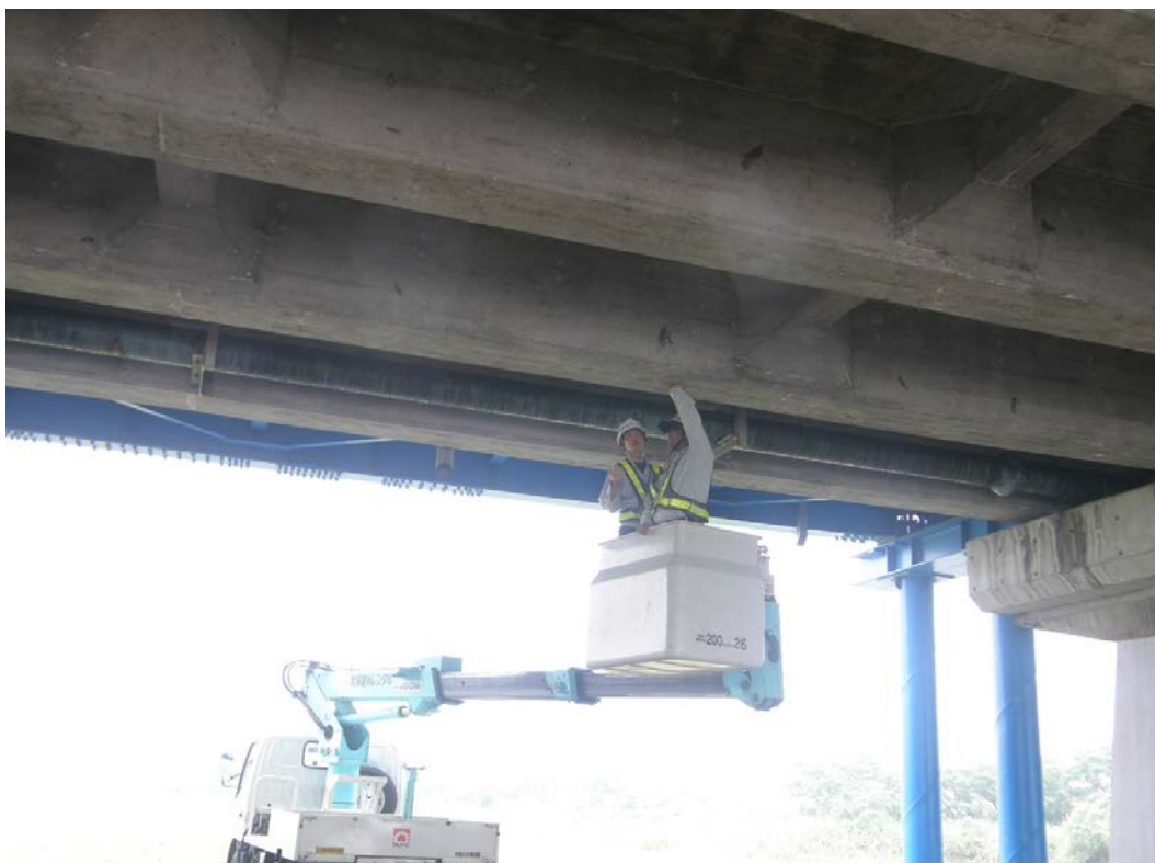
リフト車による点検
