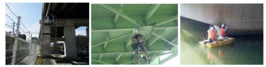
足場設置による点検
