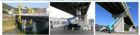
橋梁点検車による点検
