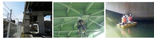
足場設置による点検
