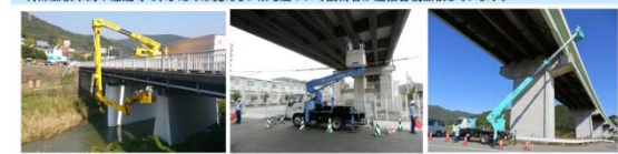
橋梁点検車による点検
