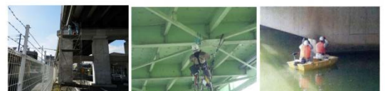
足場設置による点検
