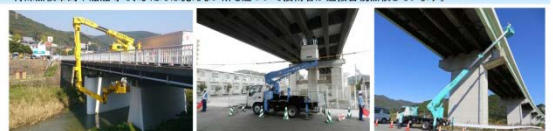
橋梁点検車による点検
