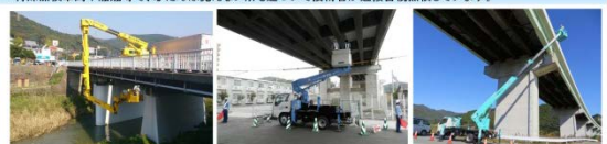
橋梁点検車による点検
