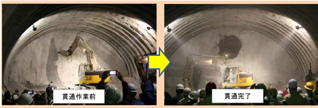
【参考】トンネル貫通イメージ（H25.4 猪八重トンネル）
