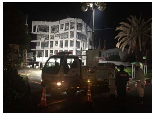
◆宇土市役所 （倒壊の恐れがある庁舎の照明活動）
