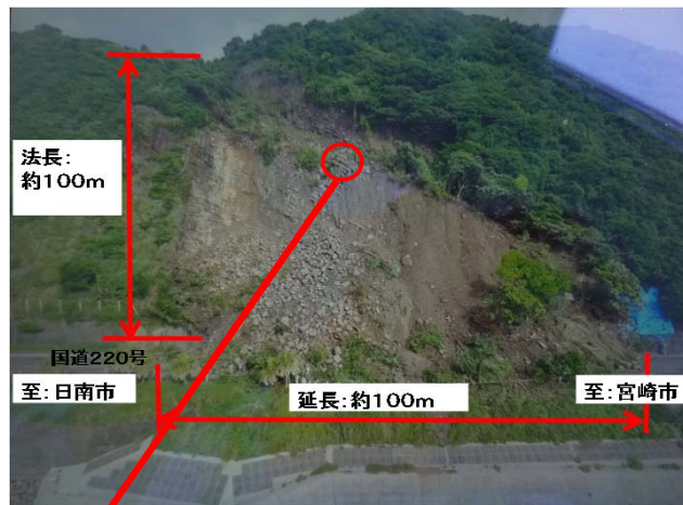
《海側からの全景》6月21日9時
