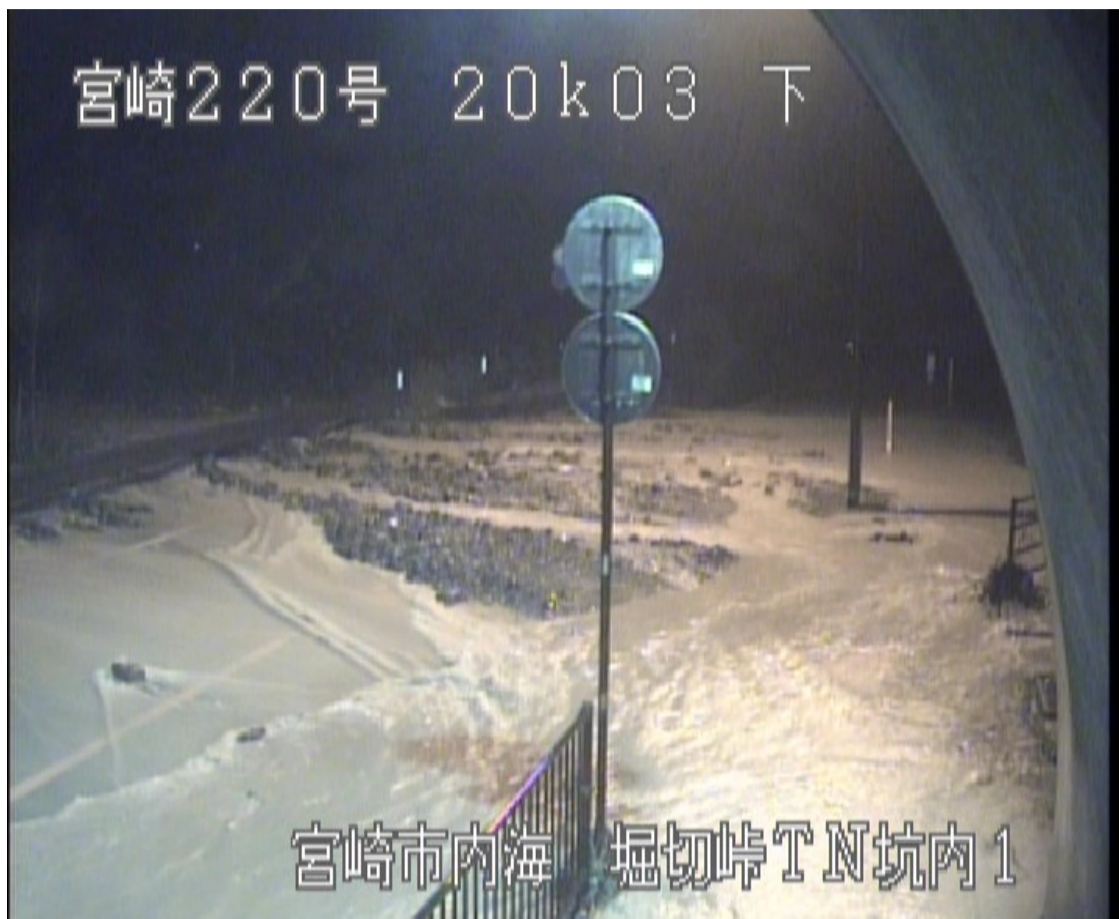
堀切峠トンネル出口(宮崎市側)の土砂流出、冠水 <10月29日5時50分頃>
