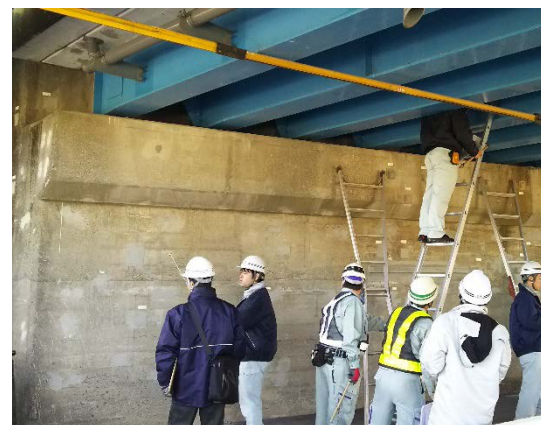
▲橋梁点検状況
