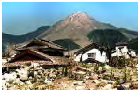
一階部分は大きな石を含む土石流に埋まりました。雨のときに川に近づくとは危険です (雲仙普賢岳1991年噴火時の土石流)
