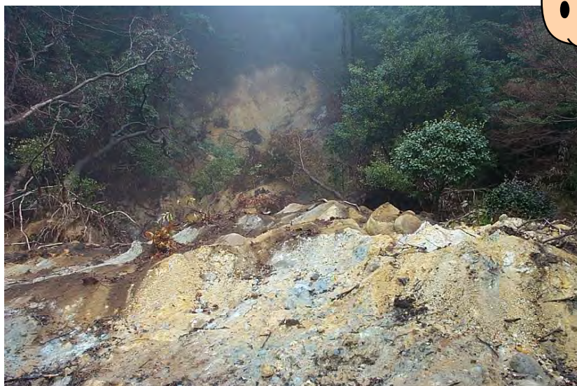
2006（平成17）年に発生した噴気地帯の地すべり（霧島市丸尾） （灰色や黄色の部分はかたい岩や石がもろくなった部分です）
