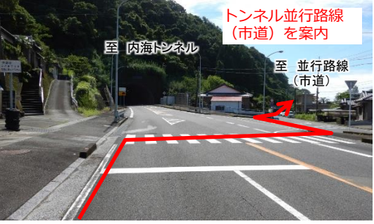
■内海加江田線(内海トンネル坑口)
