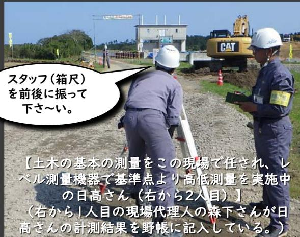
【土木の基本の測量をこの現場で任せられ、レベル測量機器で基準点より高低測量を実施中の日高さん（右から2人目）（右から1人目の現場代理人の森下さんが日高さんの計測結果を野帳に記入している。）
