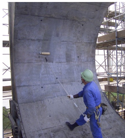
図 6-1 被膜養生剤塗布状況
