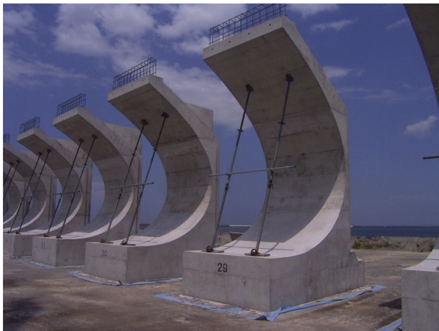
図 1-2 非越波型波返し擁壁ブロック完成写真
