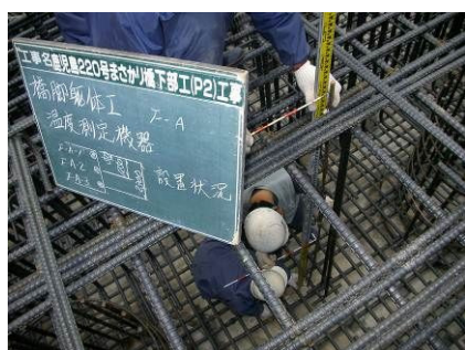
写真 3.7.1 温度測定機器設置例
