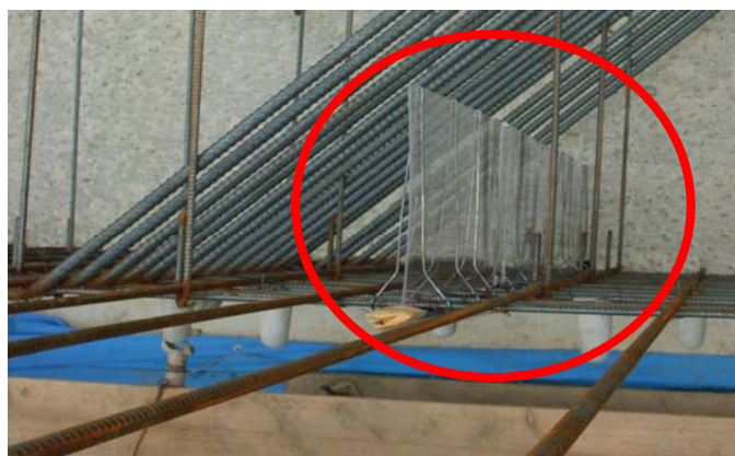
写真 3-1 ひび割れ誘発目地設置状況
