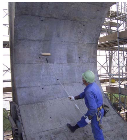
図 6-1 被膜養生剤塗布状況
