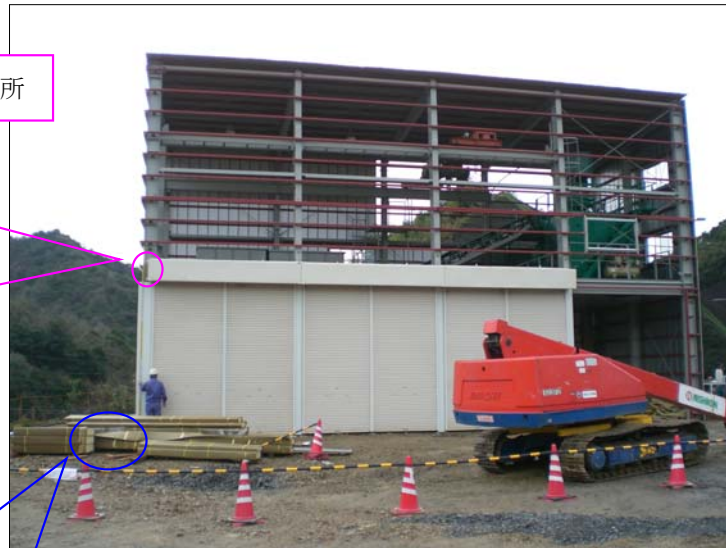
吹き付けプラント
