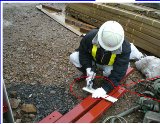
溝型鋼の上にパネルを置き切断しようとしていた
