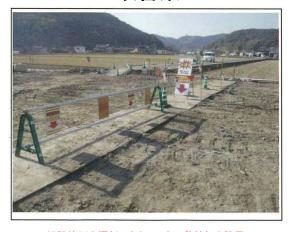
埋設箇所を掘削できないように敷鉄板を設置。 埋設物の存在がわかりやすいように、立看板等で明示。
