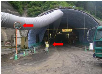
・本坑ざり出し作業中でシート台車使用時、本坑坑口部に監視員を配置。
