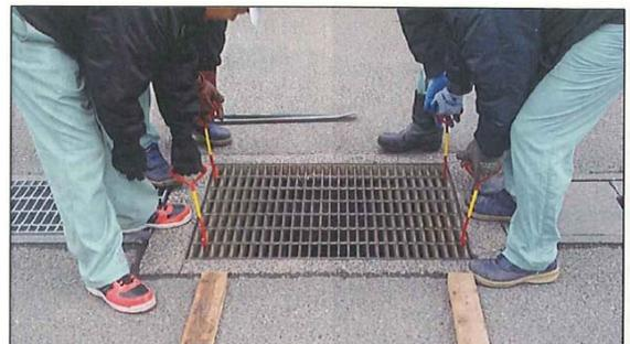
重量物のグレーチング蓋は、専用工具を使用し、適切に取り外し、設置する。
