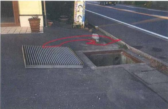
国道35号 Ok750 (下り線) 事故発生時作業状況(グレーチング柵蓋) 1000×1000×90
