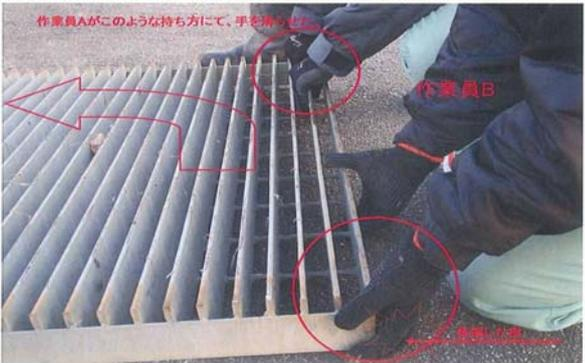
国道35号 Ok750 (下り線) 事故発生時作業状況(グレーチング柵蓋) 1000×1000×90
